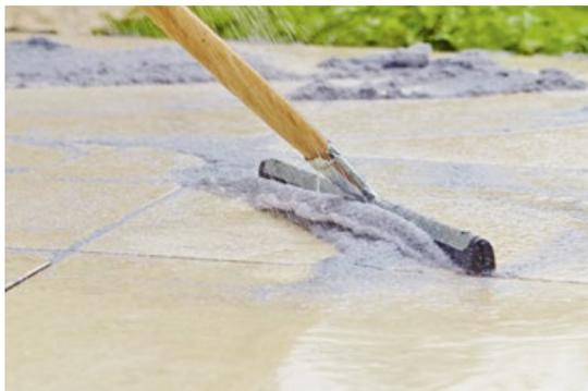
Plattenbeläge aus Keramik/Feinsteinzeug **wasserdurchlässig** verfugt. Auf wasserdurchlässiger ungebundener Tragschicht (N1 gem. ZTV Wegebau)
