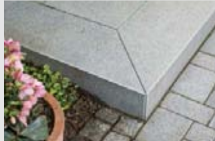
Gehrungsschnitte bei Blockstufen – ob Naturstein oder Keramik-Verbund-Produkte ...
