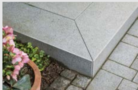
Gehungsschnitte bei Blockstufen – ob Naturstein oder Keramik-Verbund-Produkte ...
